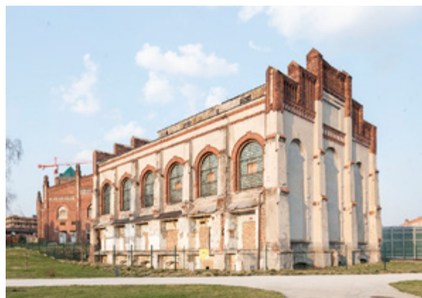
Widok budynku łaźni Gwarek przed rewitalizacją
