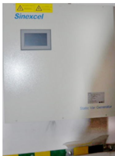
System do kompensacji mocy biernej zainstalowany w pałacu Czartoryskich
